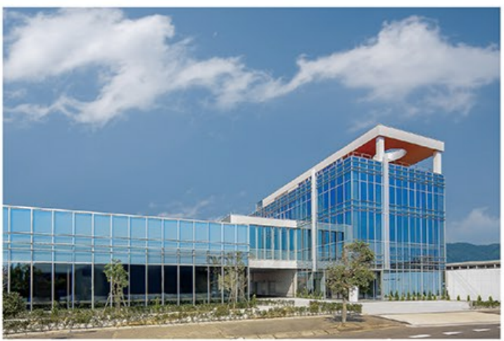
2009年に完成した社屋のテーマは「近未来」。ガラス張りの建物は、さながら都会のインテリジェントビルのよう。近くの福井県立図書館や福井市美術館とも調和している。
