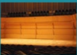
小ホールの残響調整装置。ステージ正面の壁を閉じた状態(下)と左右に開いた状態(左)。壁面の壁の中にも、残響調整装置が内蔵されている。
