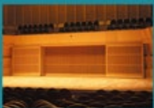
小ホールの残響調整装置。ステージ正面の壁を閉じた状態(下)と左右に開いた状態(左)。壁面の壁の中にも、残響調整装置が内蔵されている。
