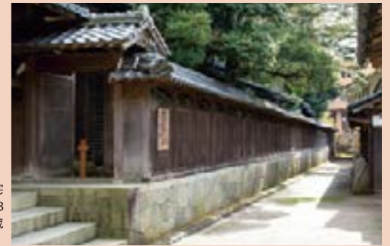
明治34年に建てられた本宅(左側)。道を挟んで山側に3棟の内蔵、海側に4棟の外蔵がある。
