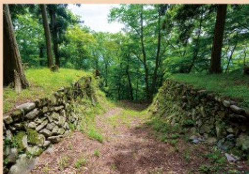
峠付近の道の両側は、石垣で固められている
